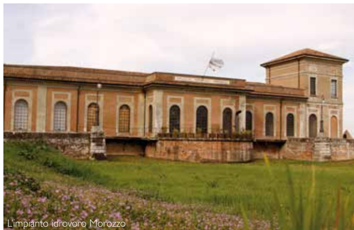
L'impianto idrovoro Morozzo
